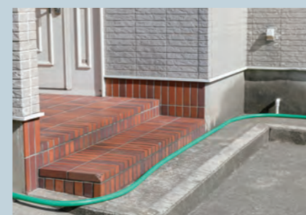
給排水ホースは妨げにならないように養生します。
