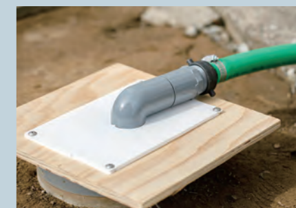
排水先は仮のマスで養生します。
