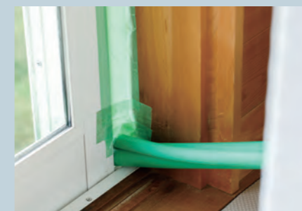
室内設置時の窓は窓ロックとテープでしっかり養生します。
